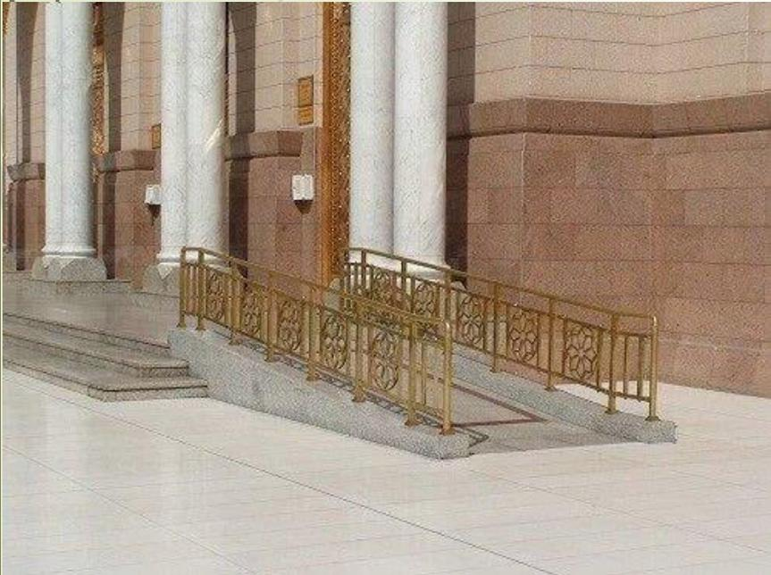
$$\frac{1 \text{ in}}{1 \text{ ft}} = \text{الميل} \quad \text{هذا يكافئ} = \frac{10 \text{ in}}{10 \text{ ft}}$$
